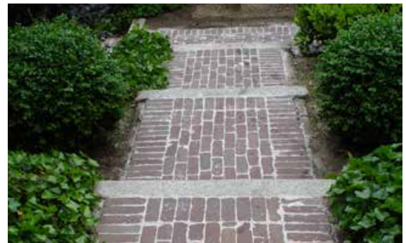
Reinigung und Einsanden
